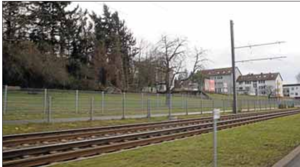
Eine Lärmschutzwand am Rande der RNV-Linie soll den Neubau vor Zug- und Autokrach abschirmen. Foto: Kreutzer
